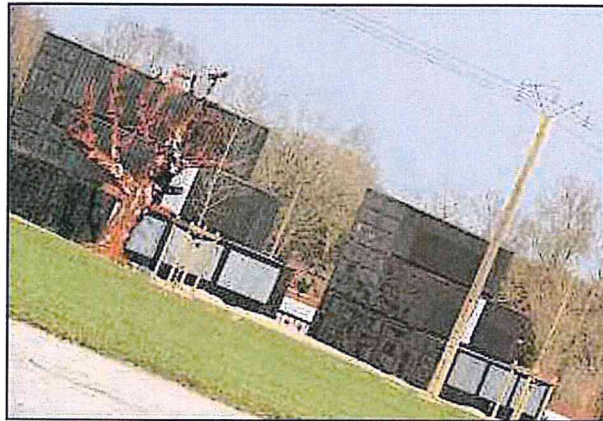
La ligne électrique traversant le site du Hellfest sera enfoncée.
